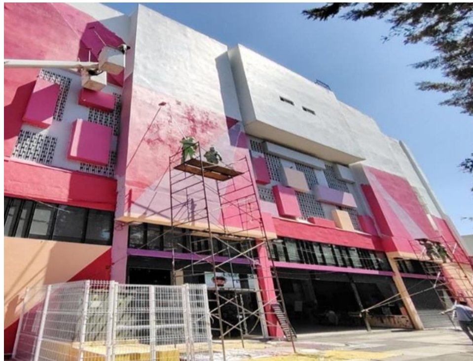
FARO Aragón - Pintura en Fachada
