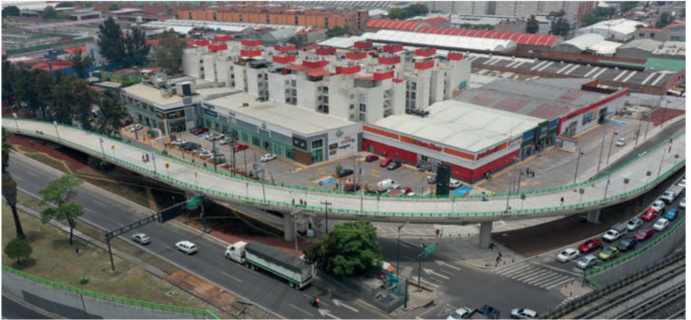
Puente vehicular Río de La Piedad- Calzada Ignacio Zaragoza
