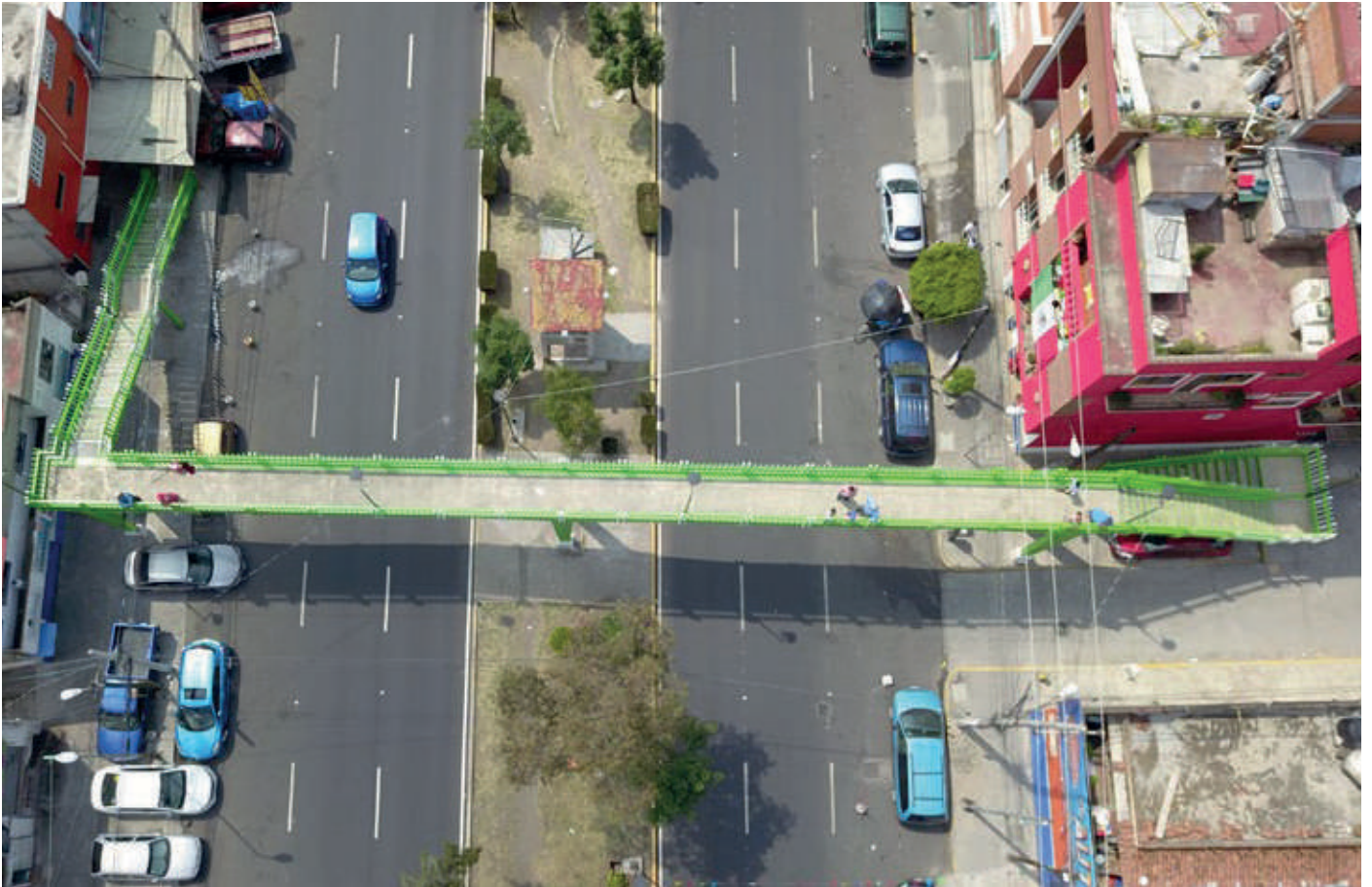
Mantenimiento Punte Peatonal
