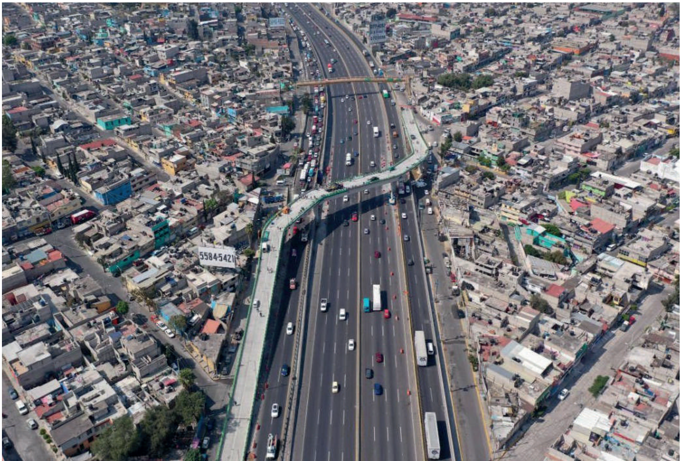
Puente Emiliano Zapata
