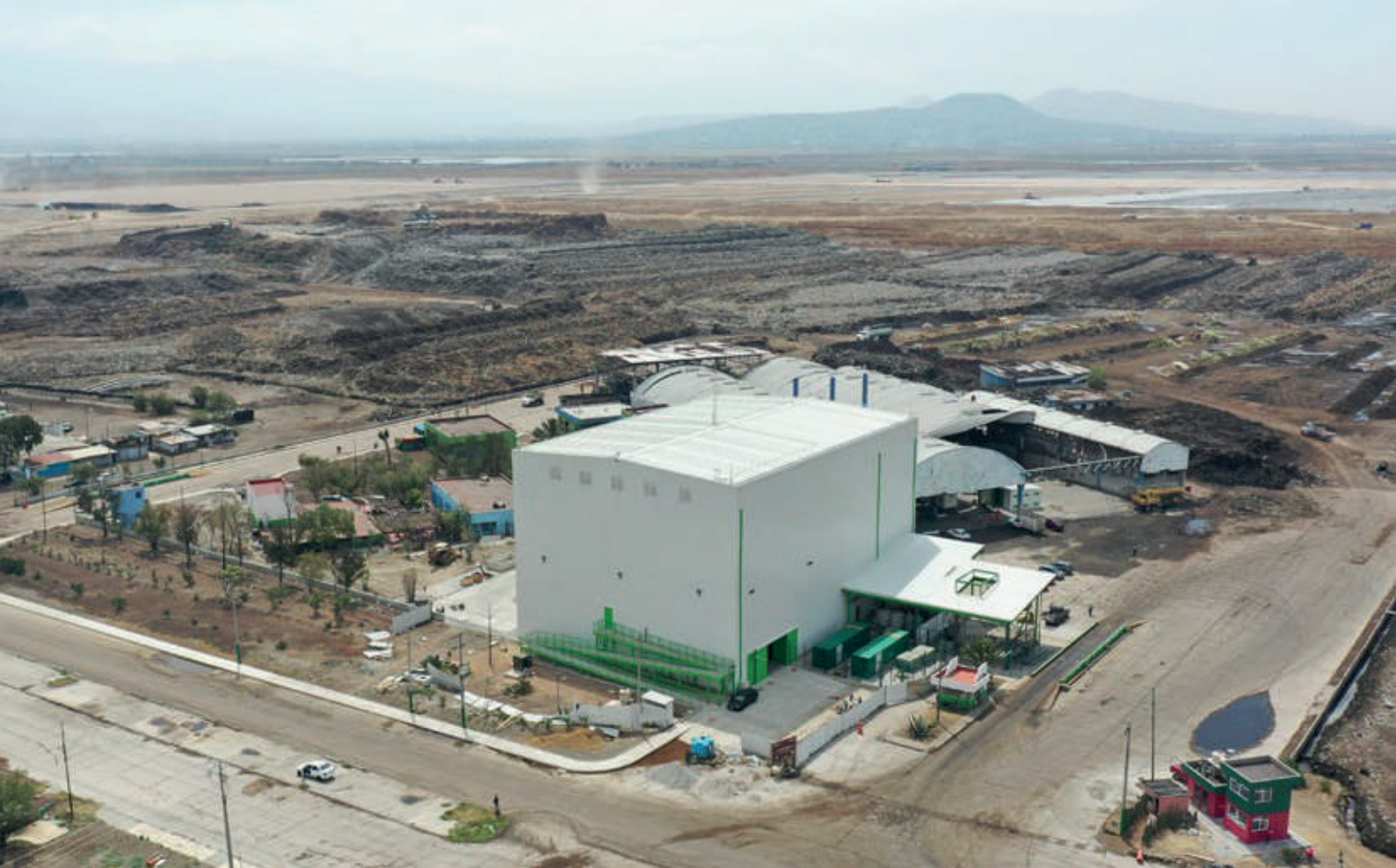
Planta de Carbonización Hidrotermal
