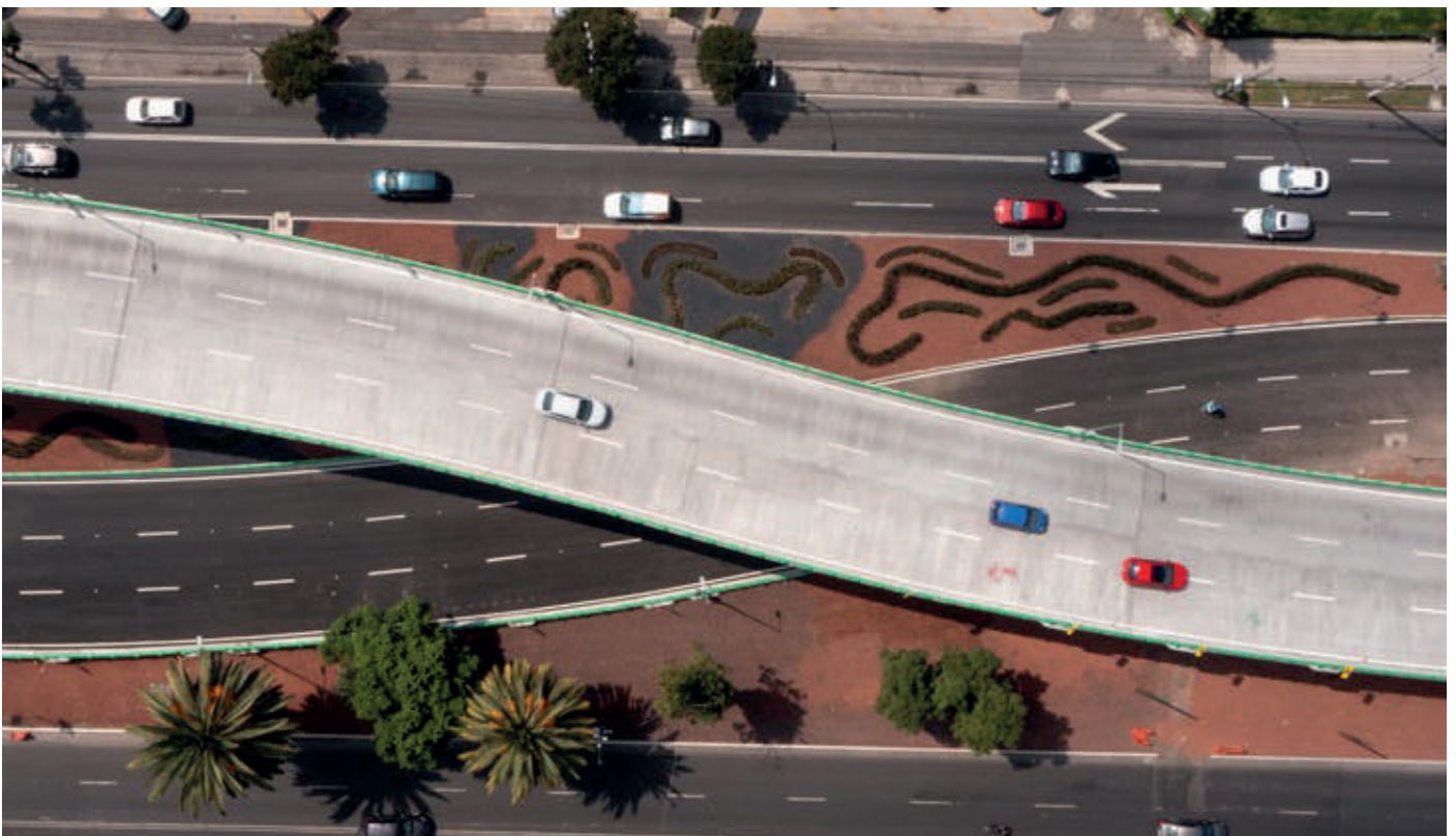
Puente Vehicular Canal Nacional "Cielito Lindo"
