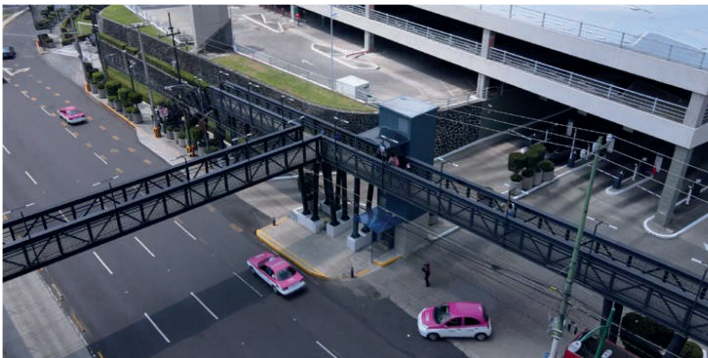
Metrobús, Estación Huipulco
