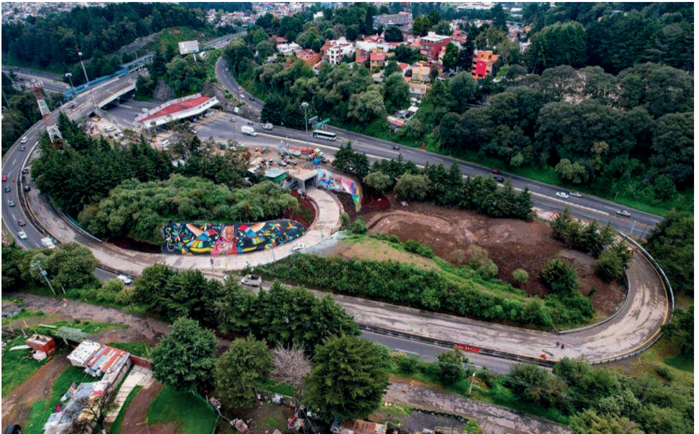
Paso a Desnivel Chamixto
