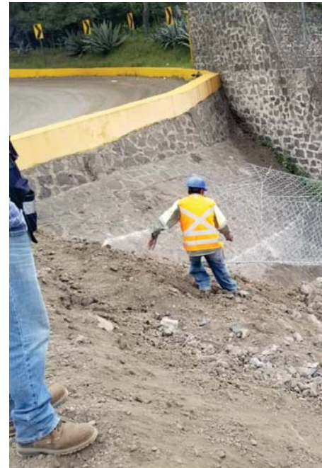
Selección de material para conformación de nuevas capas
