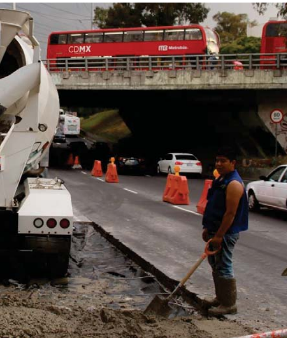
Colocación de concreto hidráulico en carril confinado.
