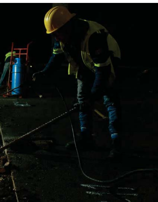
Mantenimiento de junta de calzada.
