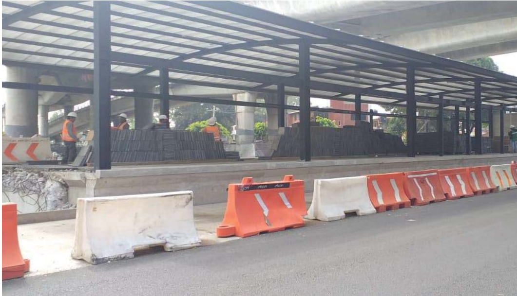
Colocación de losetas de piso en estación de la Línea 5 del Metrobús
