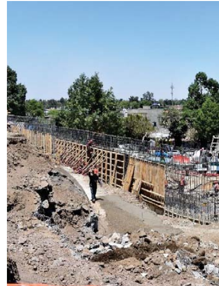
Habilitado de acero en muro de contención
