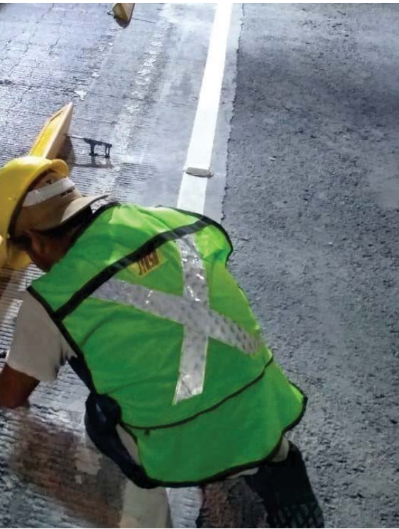
Colocación de delimitadores de carril confinado en la Línea 5 del Metrobús.
