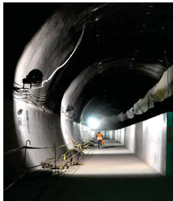
Túnel concluido con revestimiento definitivo de concreto armado.
