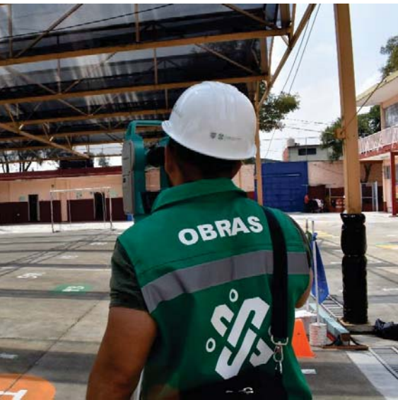
Escuela Adriana García Corral, plantel en reconstrucción.
