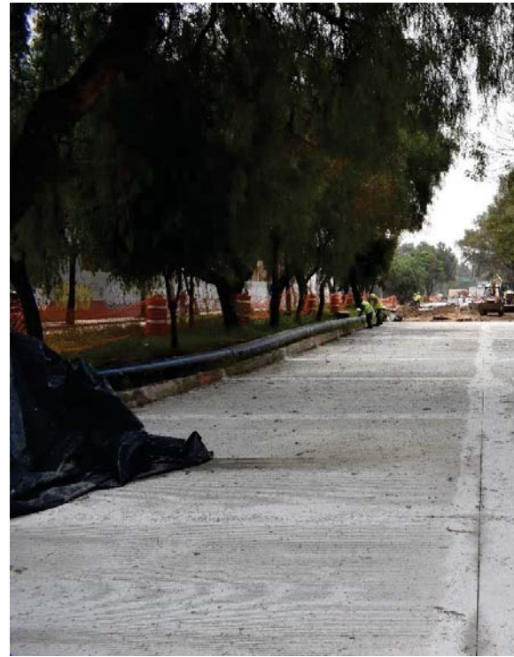
Acabado final en losas de Concreto hidráulico.
