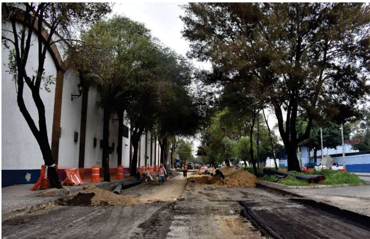
Retiro de pavimento en malas condiciones.
