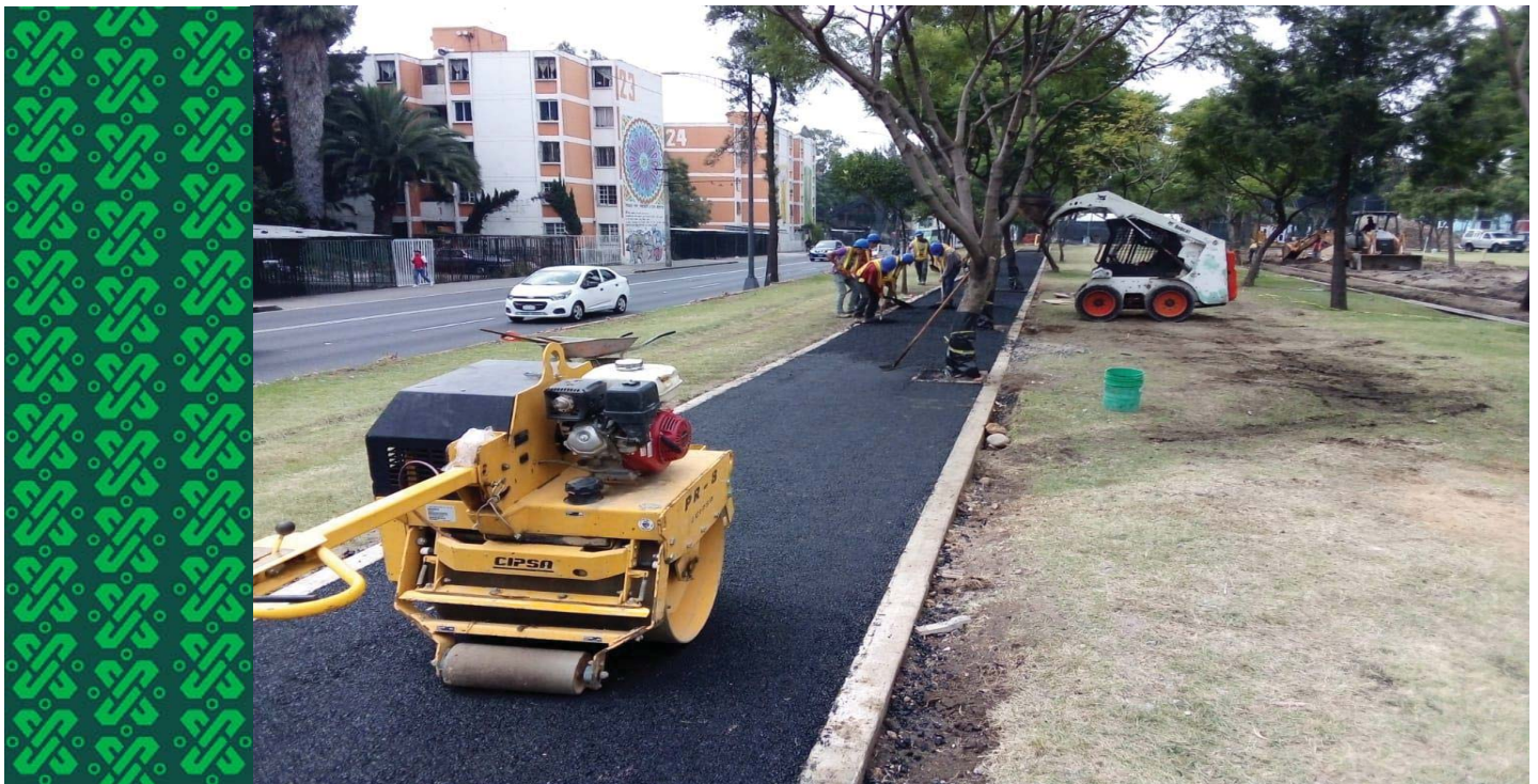
Colocación de asfalto en ciclopista, Periférico Oriente.
