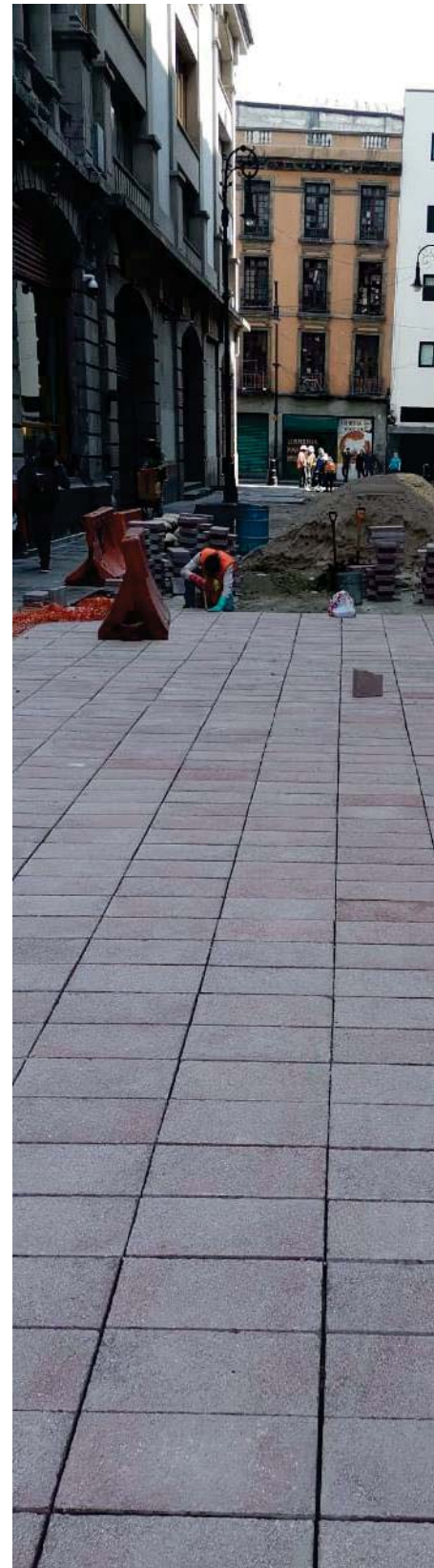
Colocación de loseta basáltica.
