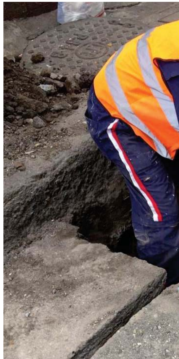
Construcción de registro de instalación eléctrica.
