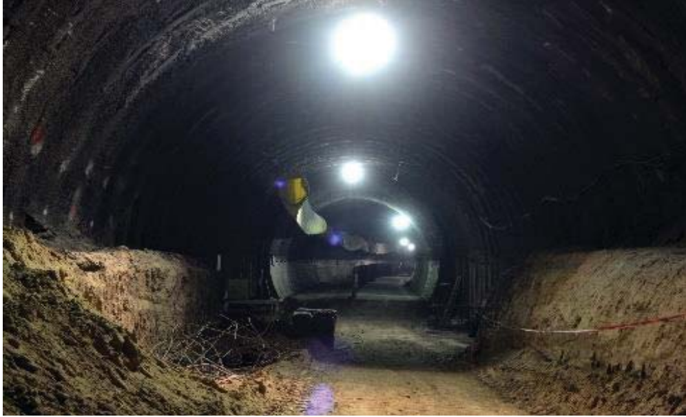
Excavación de sección media inferior de túnel para la Ampliación de la Línea 12 del Sistema de Transporte Colectivo Metro
