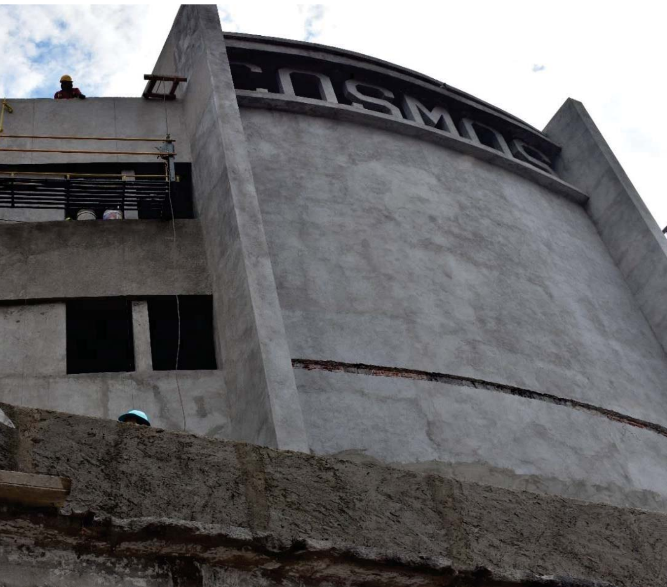
Aplanado con mortero en fachada principal.
