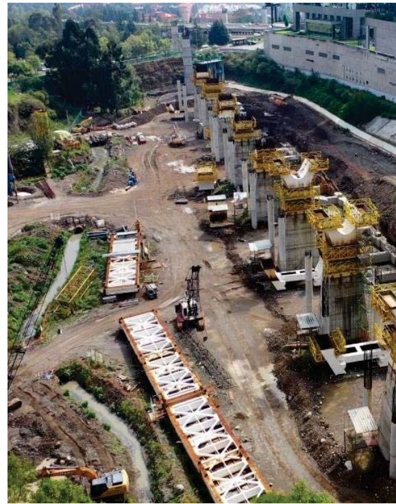
Frente de trabajo en estación Santa Fe.
