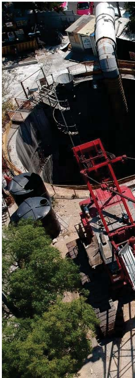
Vista aérea de acceso a lumbrera.
