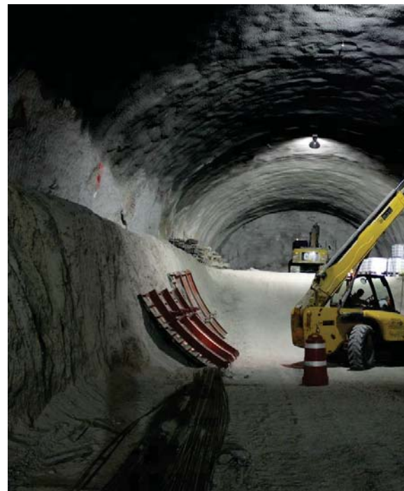
Colocación de revestimiento de concreto.
