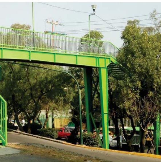
Conclusión de los trabajos de rehabilitación de puente peatonal ubicado en San Gregorio.
