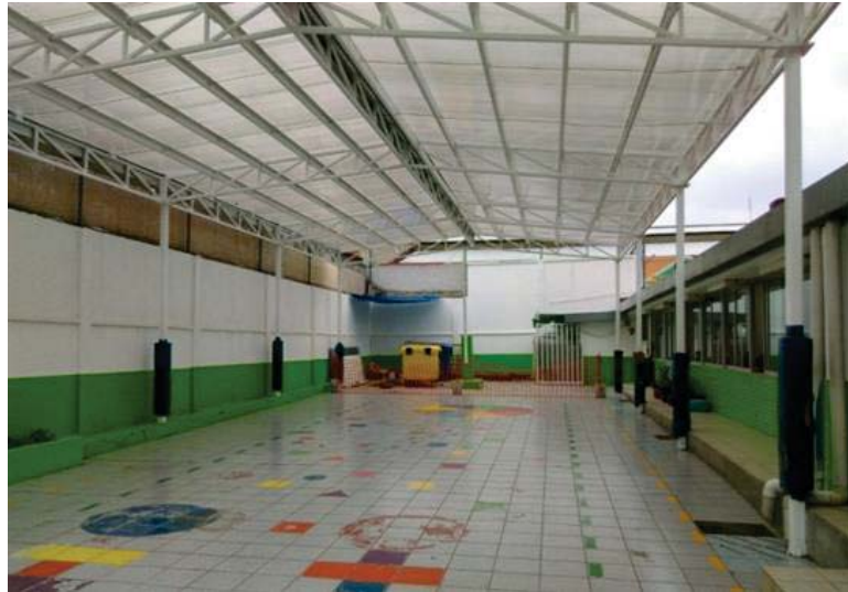
Rehabilitación de estructuras metálicas de soporte de lonarías y mallas.
