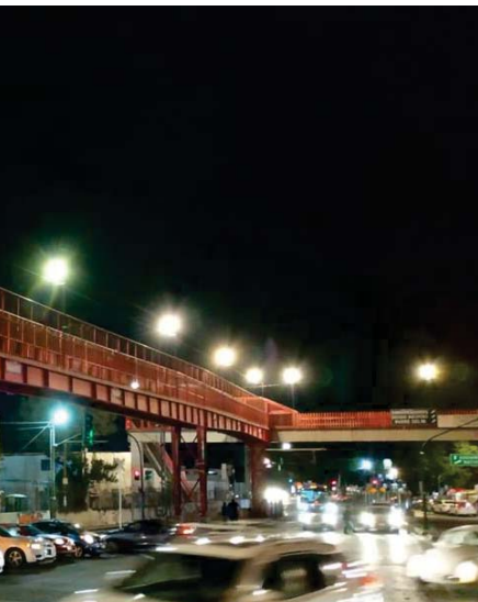
Instalación de alumbrado público en puente peatonal
