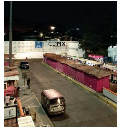
Colocación de nuevo luminario en CETRAM.
