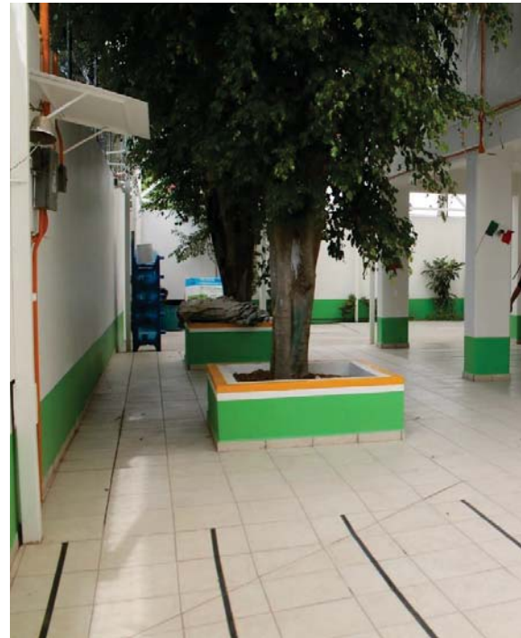
Aplicación de pintura en Columnas y jardineras.
