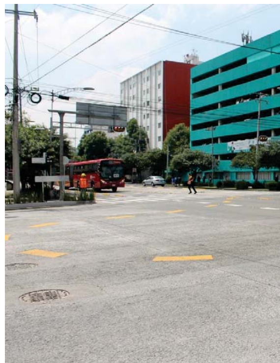
Balizamiento de trayectoria del Metrobús.
