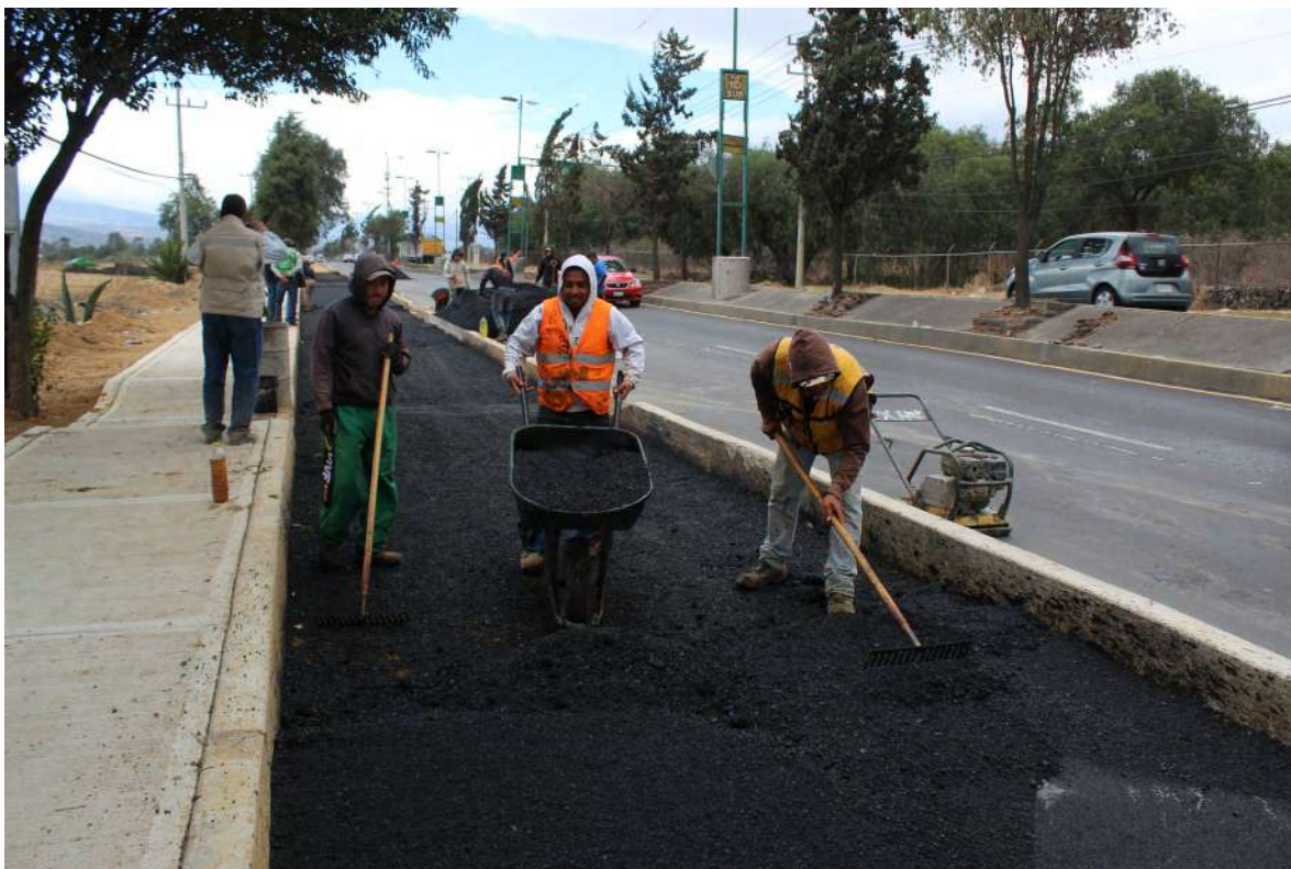
Imagen 00 | Construcción de Infraestructura Ciclista, SOBSE 2020.
