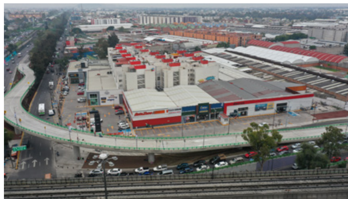
Puente Vehicular , Río de la Piedad a Calzada Ignacio Zaragoza
