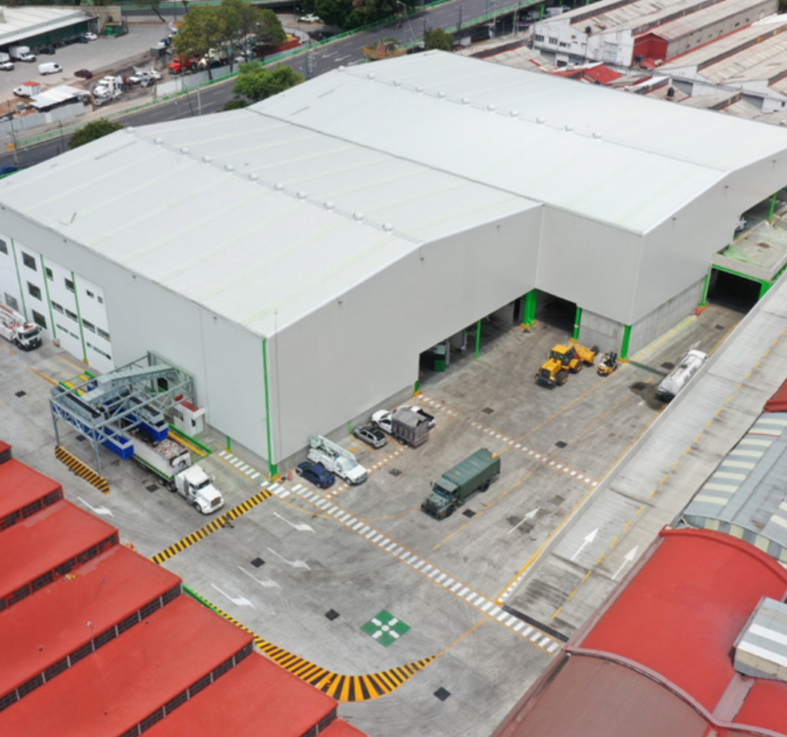
Estación de Transferencia y Planta de Selección Azcapotzalco
