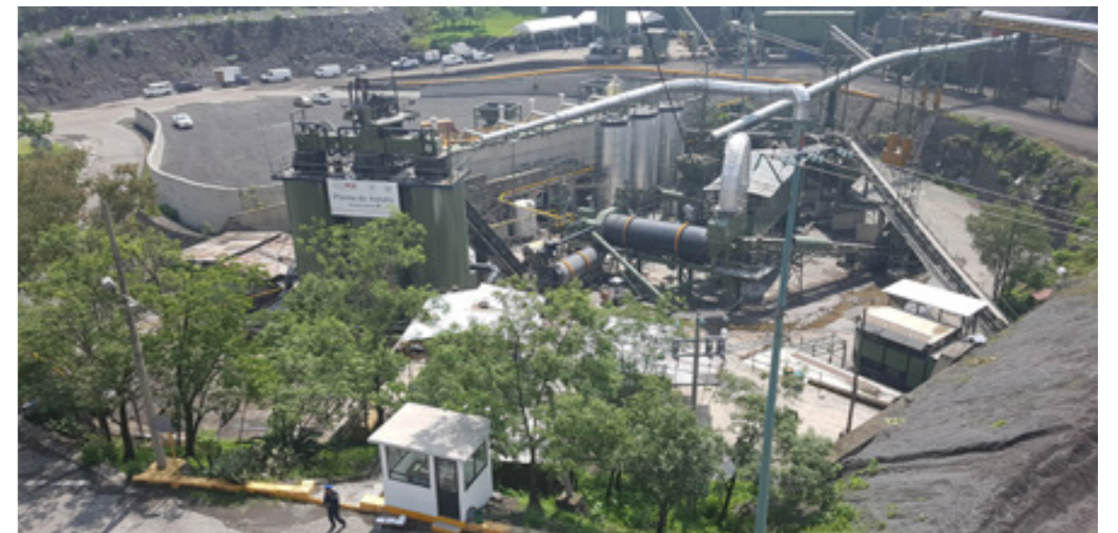
Planta Productora de mezclas Asfálticas de la Ciudad de México
