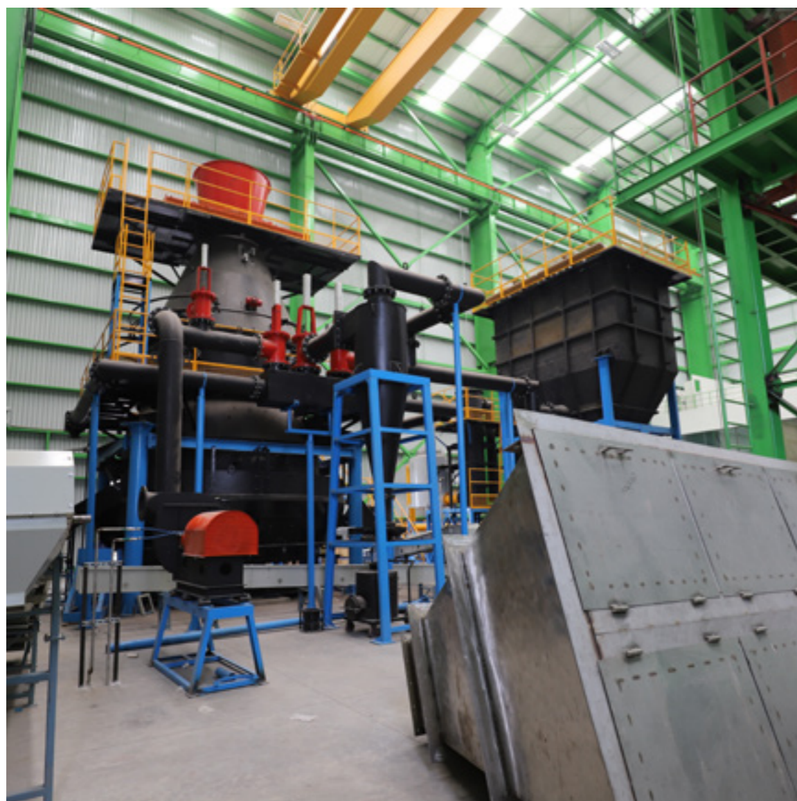
Instalación de la Planta de Carbonización Hidrotermal
