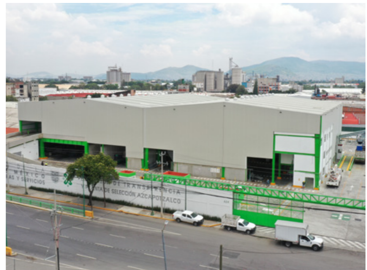
Estación de Transferencia y Planta de Selección Azcapotzalco
