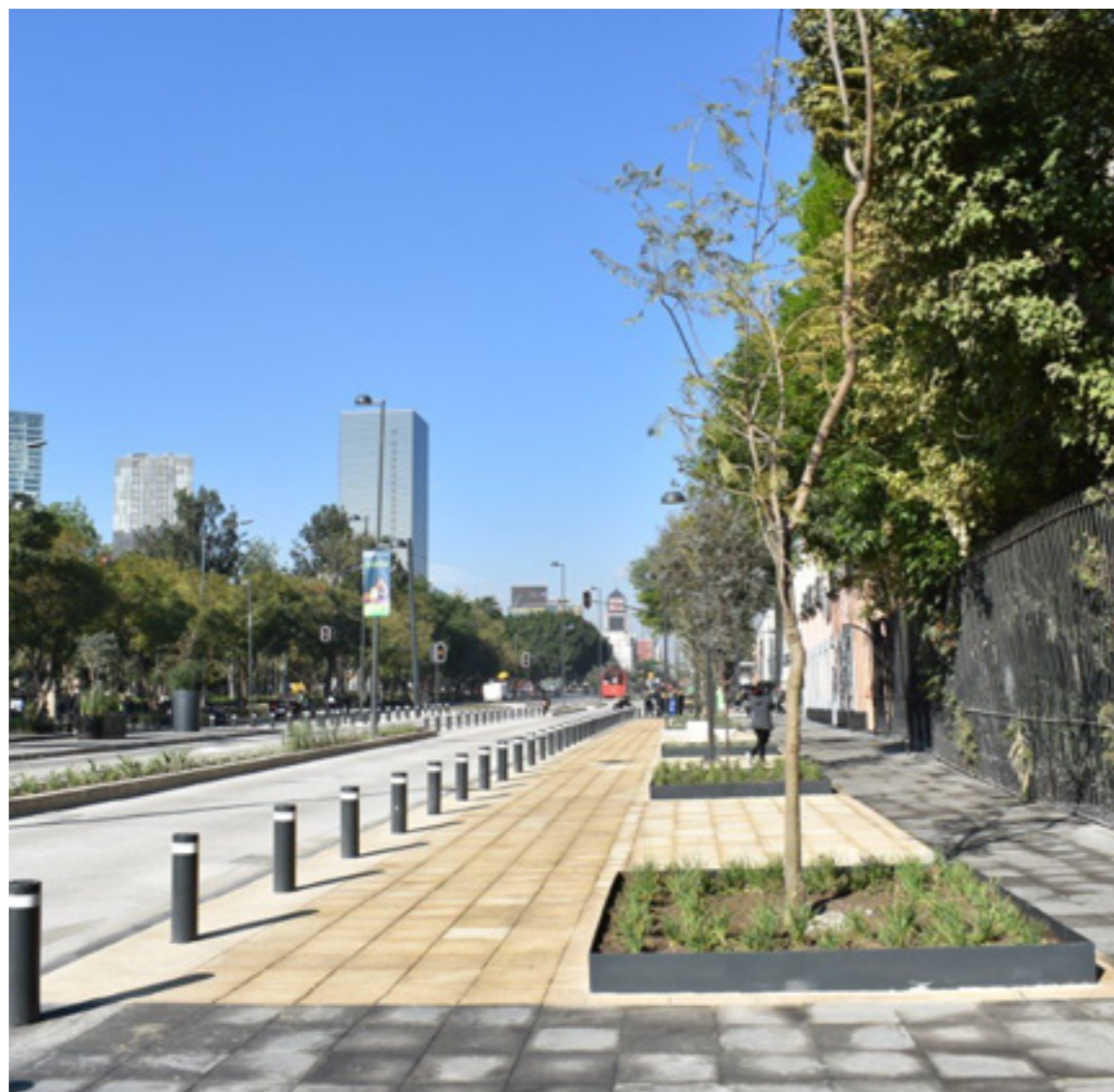
Rehabilitación de banquetas y guarniciones
