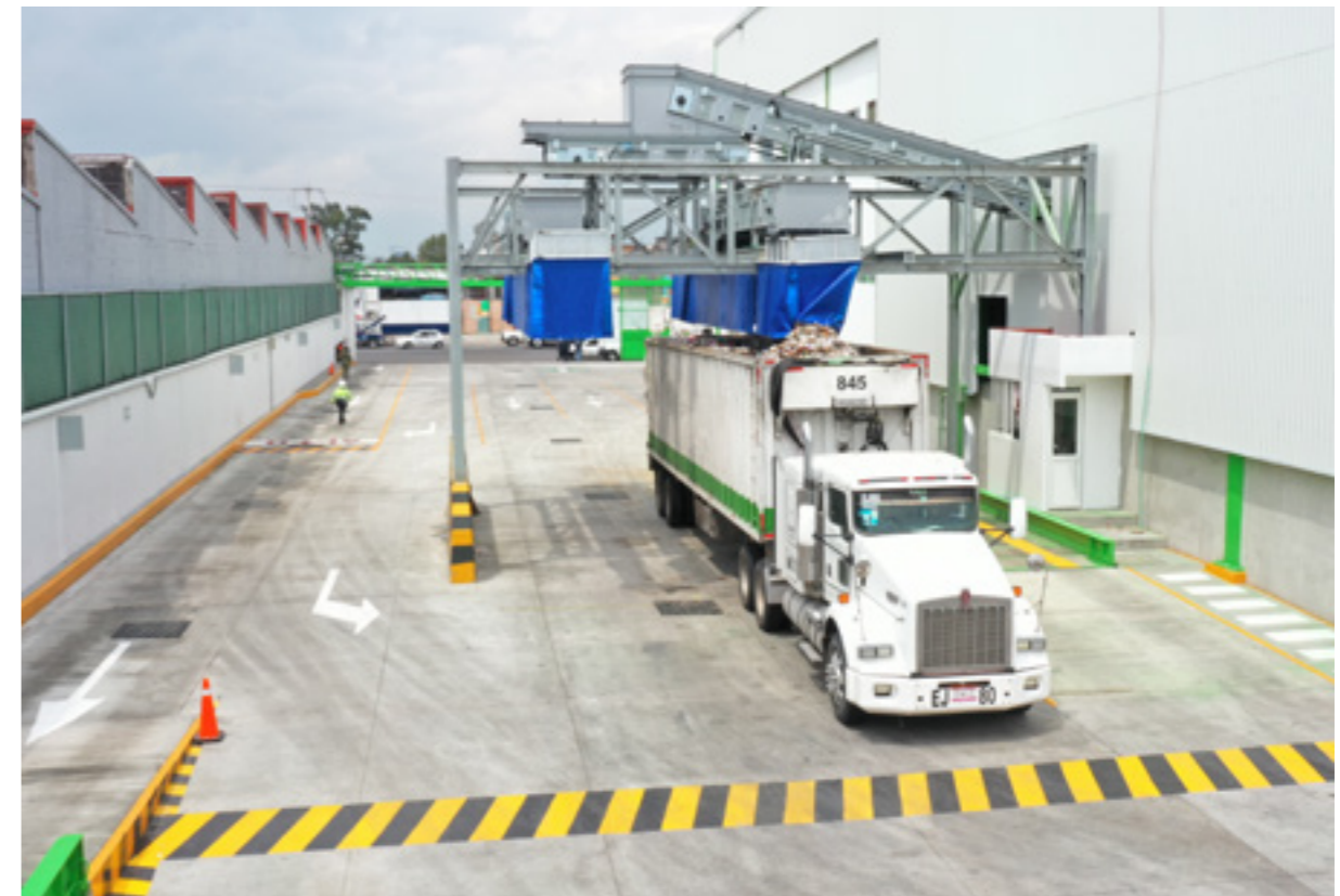
Estación de Transferencia y Planta de Selección Azcapotzalco
