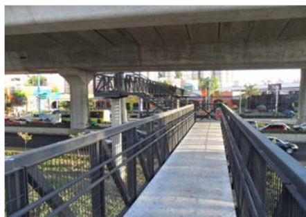
Puente peatonal John F. Kennedy y Periférico Sur
