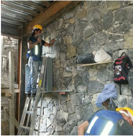
Ejecución de los trabajos en el interior del inmueble
