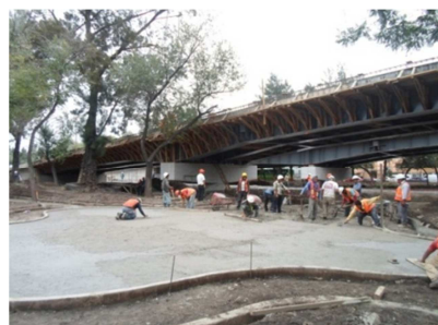
Puente Tezontle poniente
