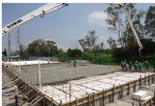
Vista del colado de losa de desplante
