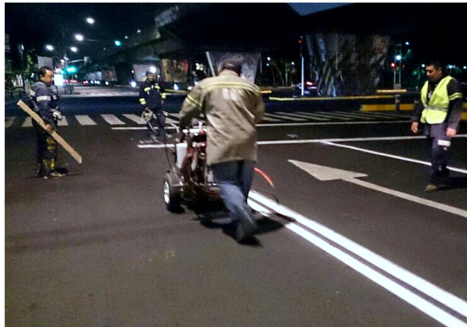
Balizamiento de doble línea (Av. Congreso de la Unión y Av. Fray Servando Teresa de Mier)
