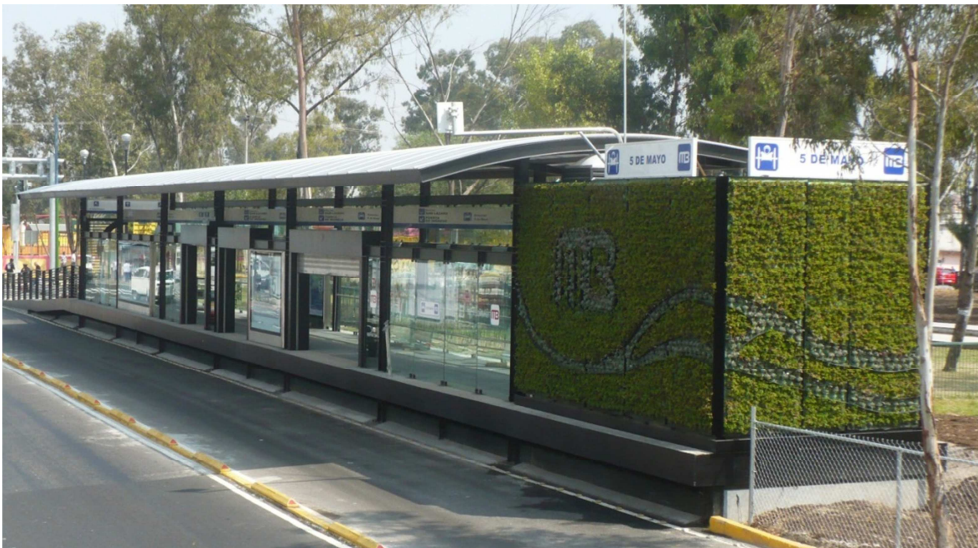
Vista de estación con elementos prefabricados y jardín vertical Línea 5 Metrobús
