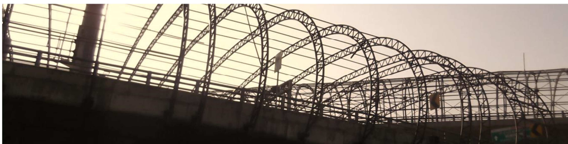
Estructura metálica de protección del asta bandera
