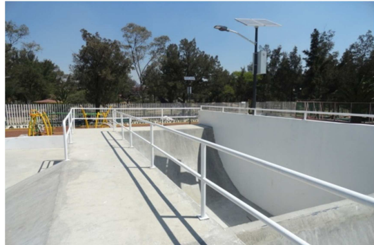
Vista de pista de patinetas y aparatos ejercitadores
