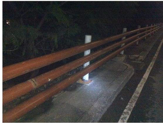
Vista de parapeto metálico colocado
