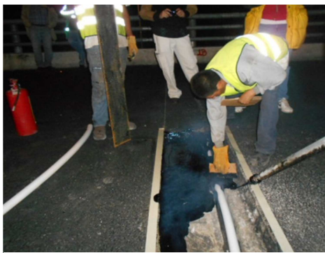
Tendido de adhesivos en juntas matrix
