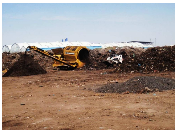
Trabajos de cribado de composta
