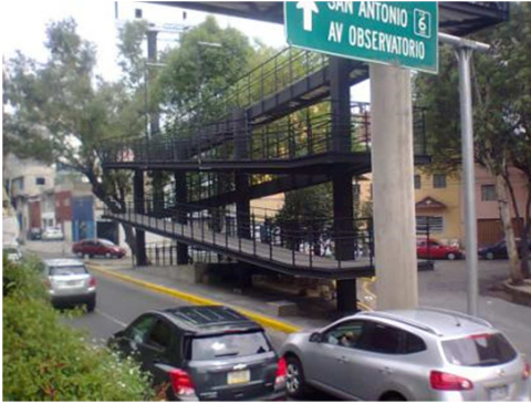
Puente peatonal Sóstenes Rocha
