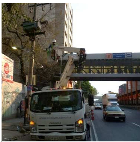
Mantenimiento de Alumbrado Público en Calz. de Tlalpan
