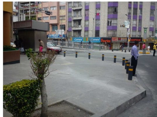
Rampa de abanico y bolardos en Av. Cuauhtémoc, esq. Calle Puebla
