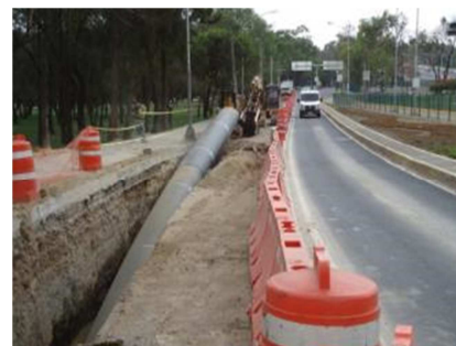
Colocación de colector de 1.07 m de diámetro Anatole France y Reforma
