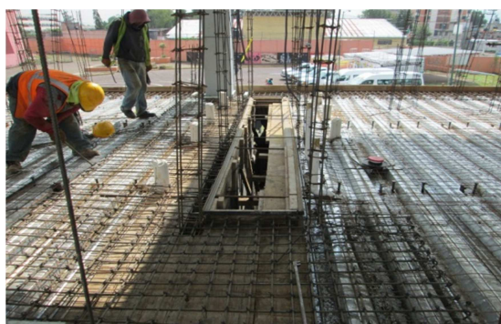
Habilitado de acero en losa de entrepiso
