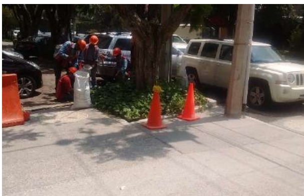
Evaluación a instalaciones subterráneas
