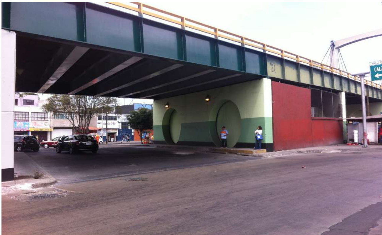
Puente vehicular Periférico Canal de San Juan
