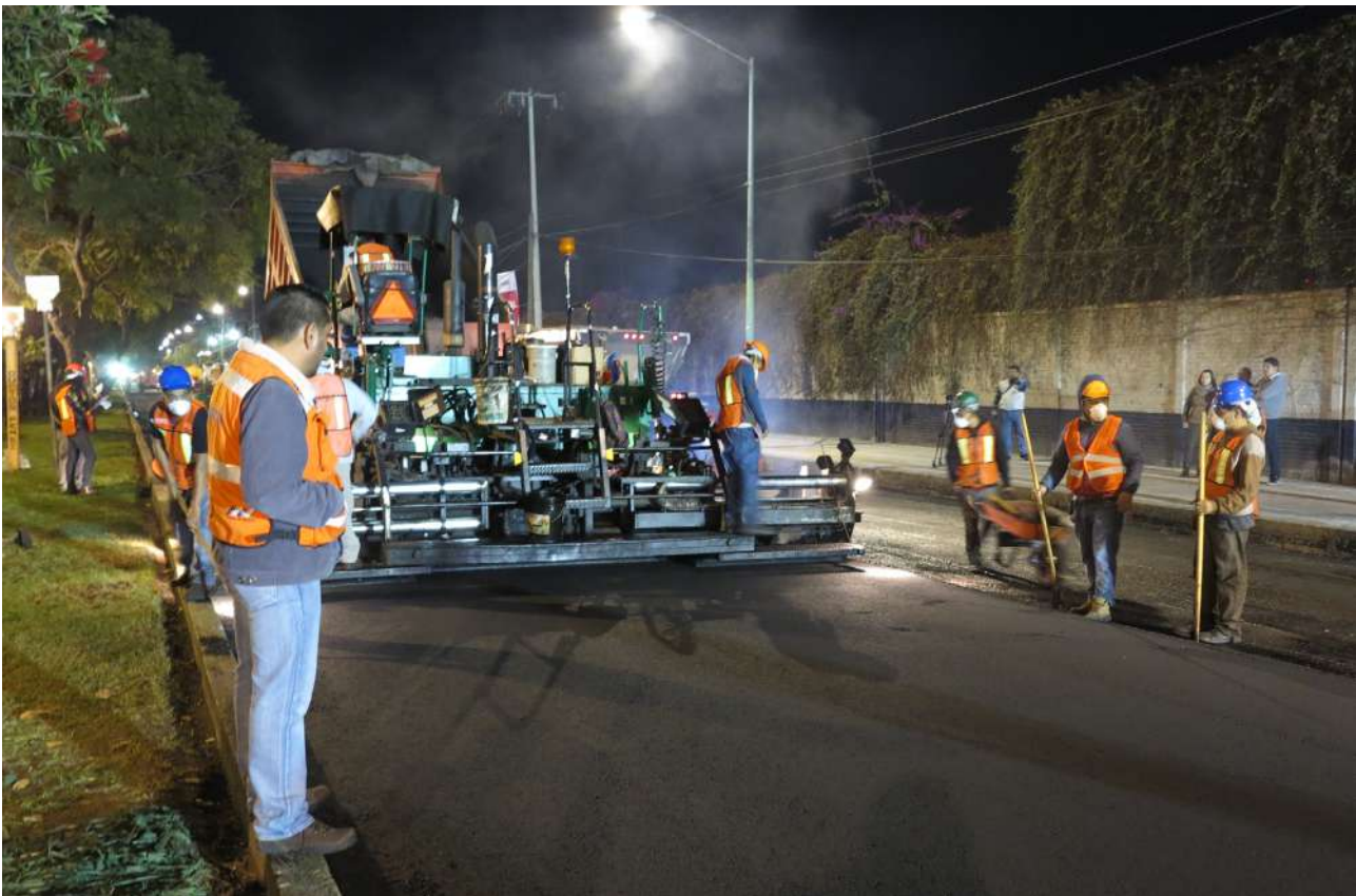
Preparación del tren pavimentador para trabajo nocturno
