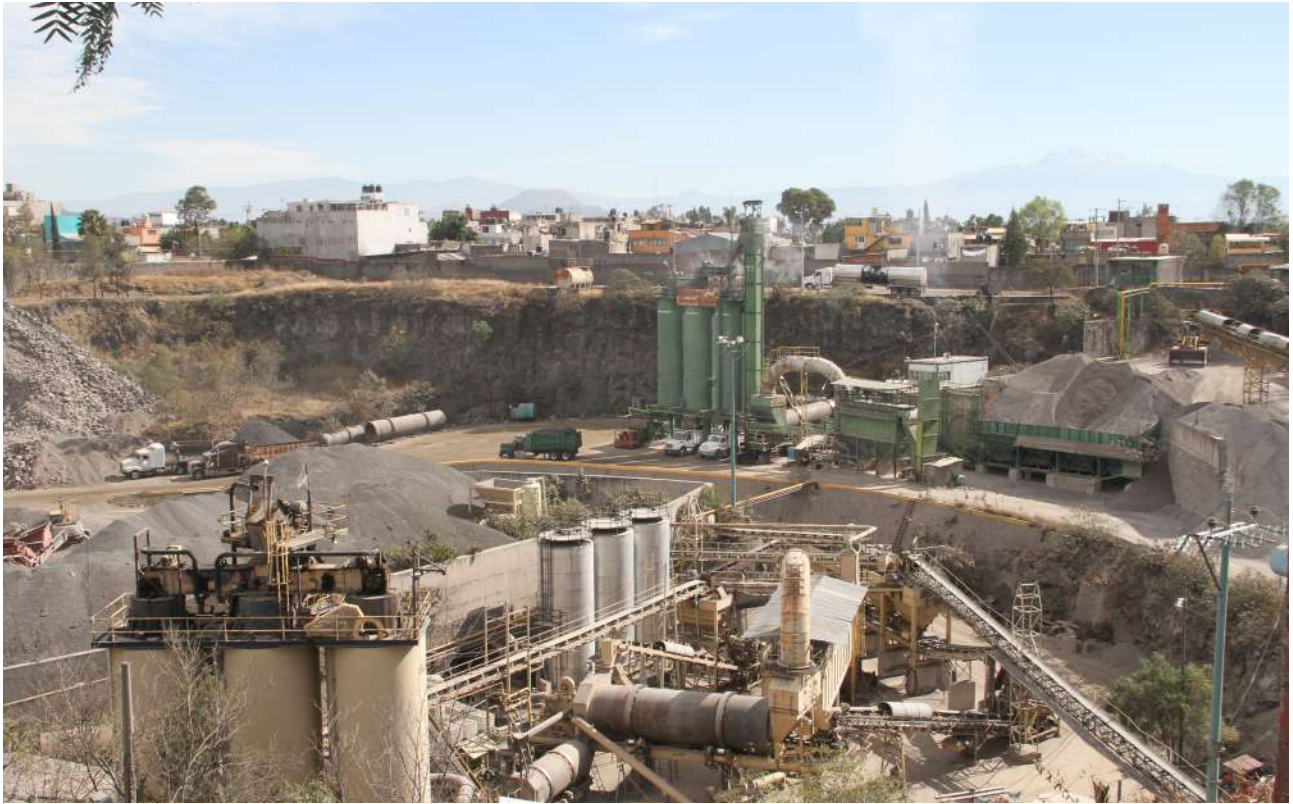
La mejora de esta edificación será integral pues además de adecuar los procesos de fabricación de asfalto , los habitantes aledaños podrán disfrutar de la remodelación de esta zona
