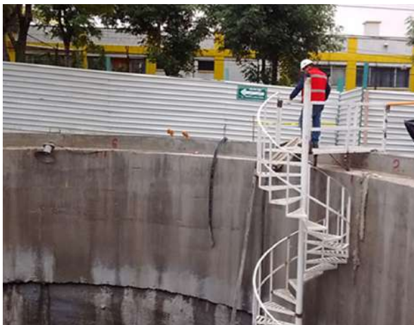
Brocal terminado (primer anillo perimetral)
