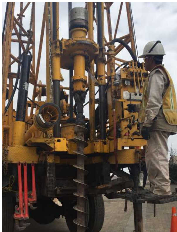
Los trabajadores operan cuidadosamente la maquinaria para ser precisos en el desarrollo de las labores
