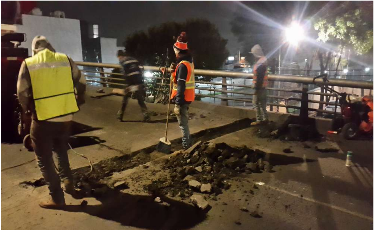
Puente en Eje 3 Oriente y Eje 3 Sur
