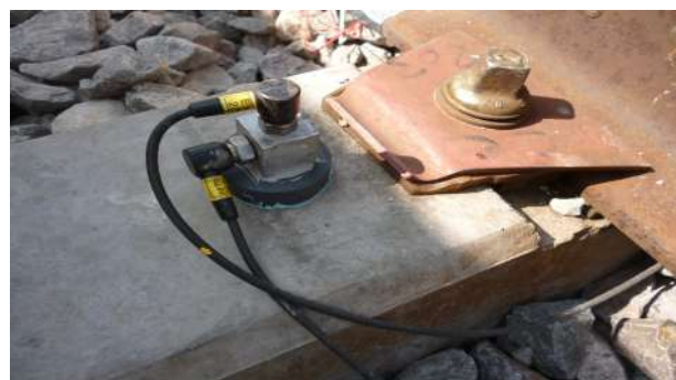
Sustitución de elementos de fijación
