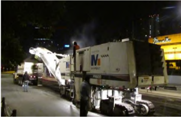
Operación del equipo de fresado
