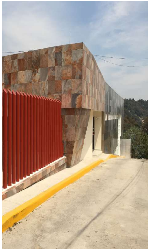
Espacios como el Centro de Salud Acopilco representan modernidad para la infraestructura de salud
