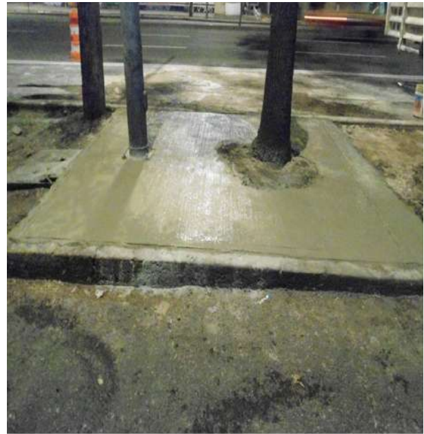
Colado de banqueta
