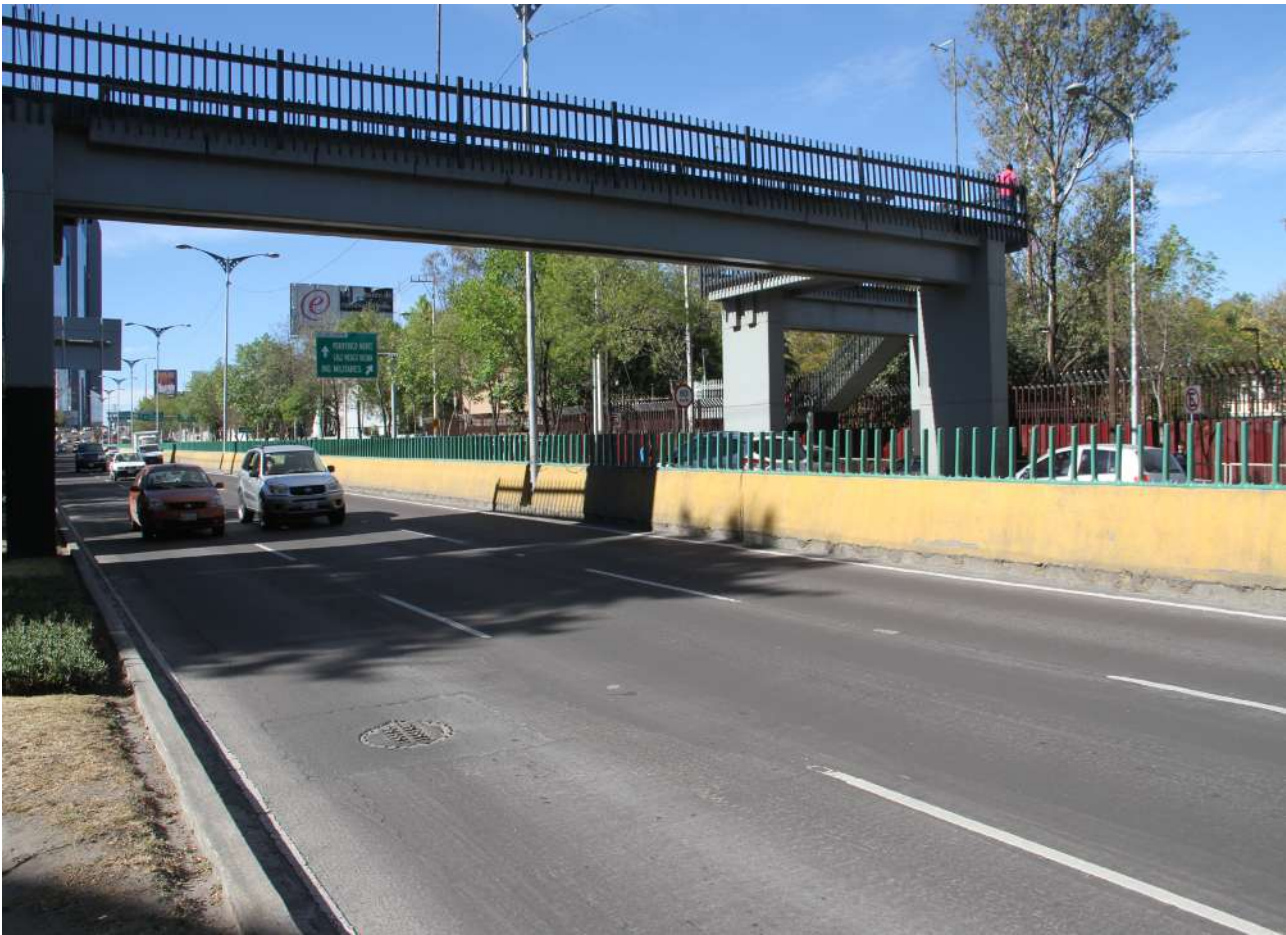
Trabajos de aplicación de pintura
