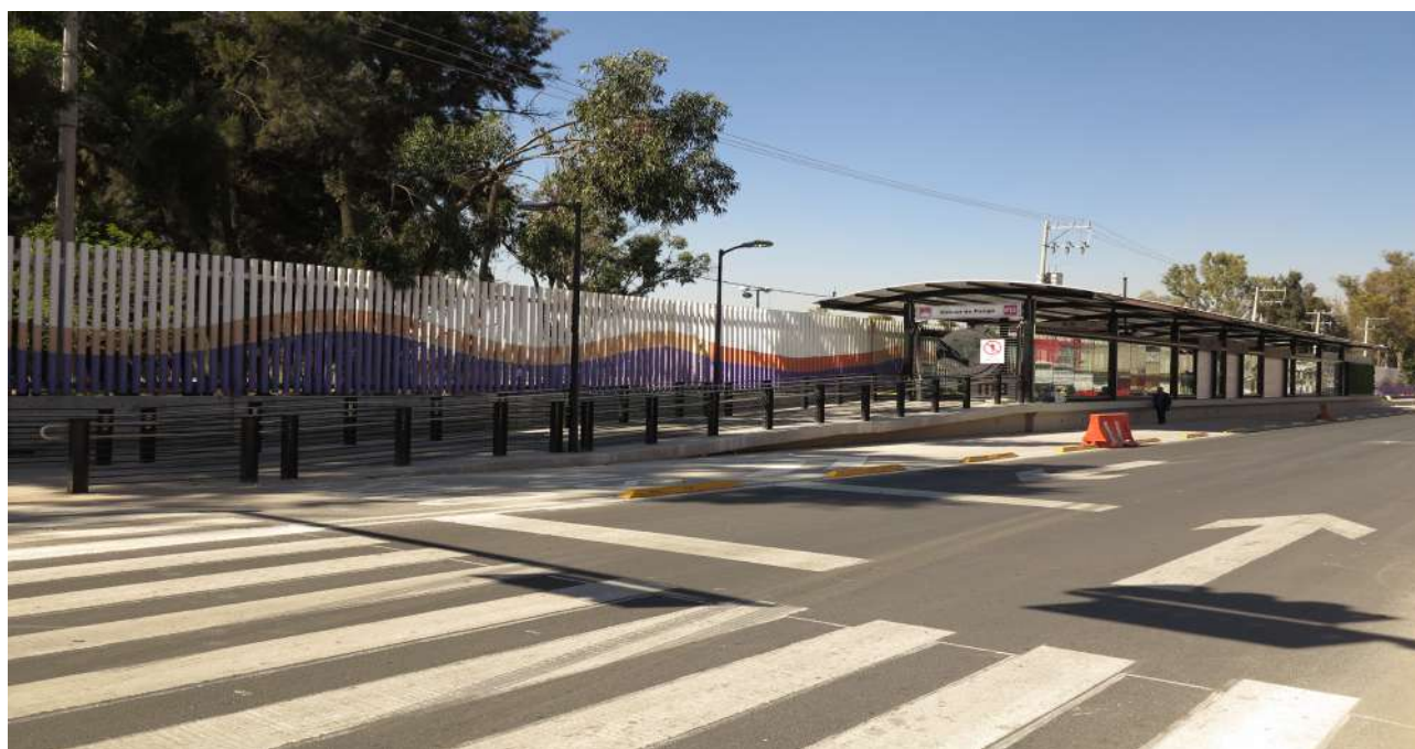
Señalamiento horizontal: balizamiento en carriles y cruces
