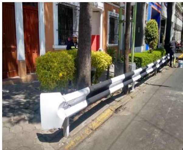
Aplicación de pintura en defensa metálica
