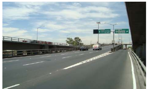
Balizamiento de flechas de bifurcación y colocación de vialetas
