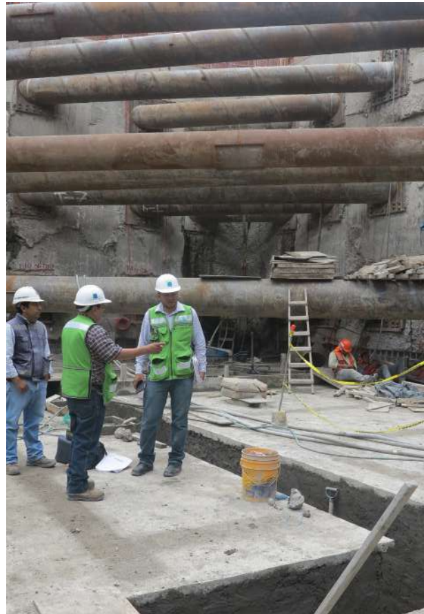
La supervisión de todos los elementos de la obra es minuciosa
