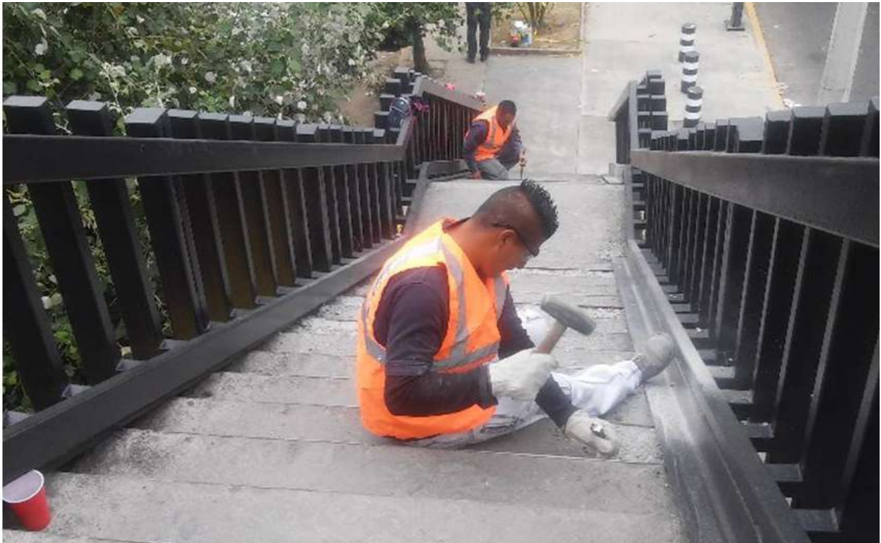
Reparación de escalones
