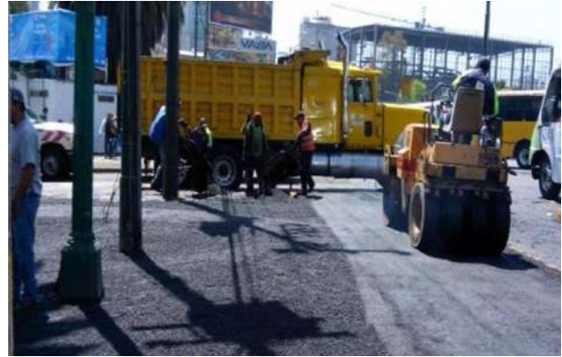
Compactación de tendido de la mezcla asfáltica
