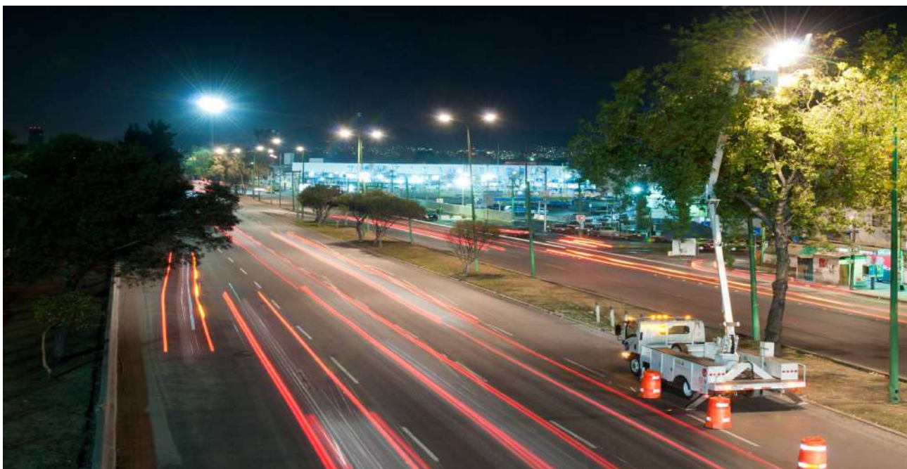
Sustitución de luminarios en vialidad primaria
