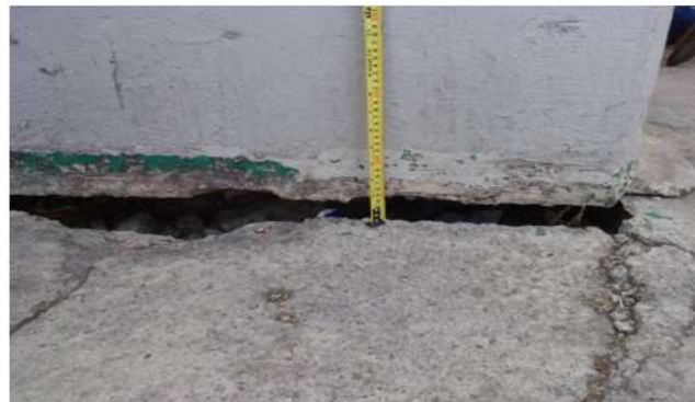
Trabajos de ajuste en los pilotes de control
