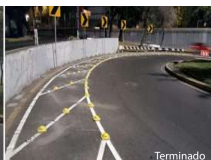
Balizamiento de: línea continua y flecha sencilla
