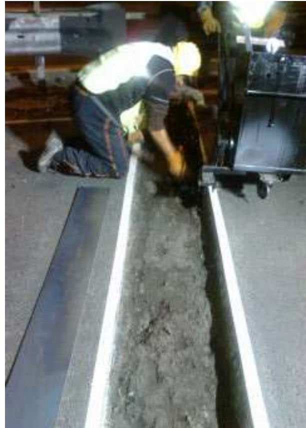
Corte de asfalto para retiro de junta
