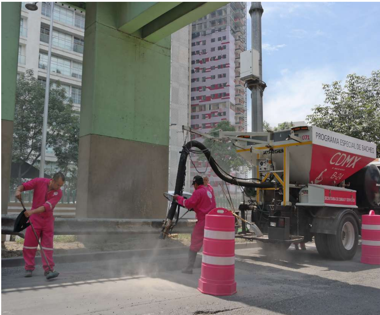
Tendido de material asfáltico (Brigadas Bache 24 )
