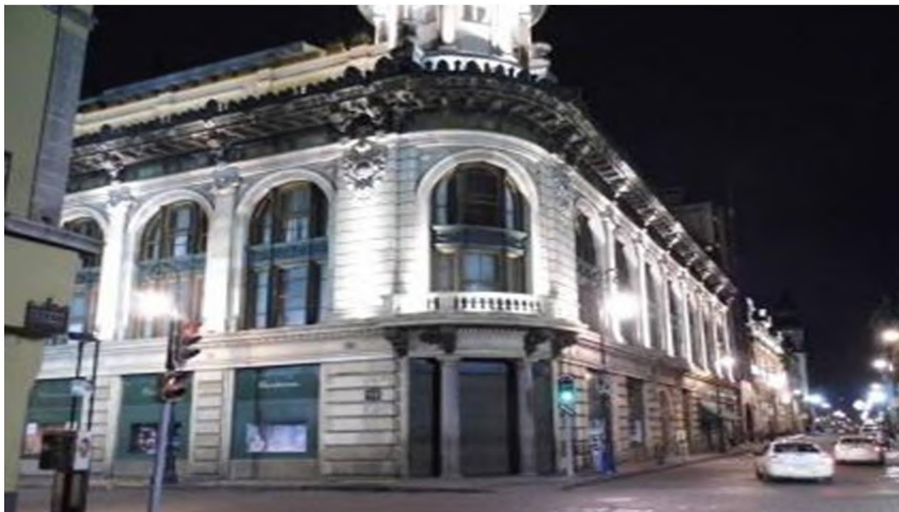
Iluminación de fachadas en edificios históricos
