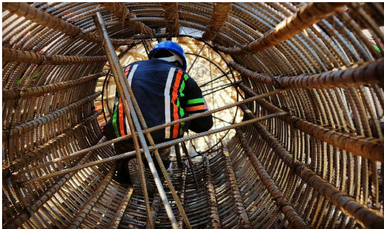
Armado de columnas coladas en sitio
