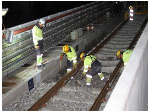
Sustitución de balasto
