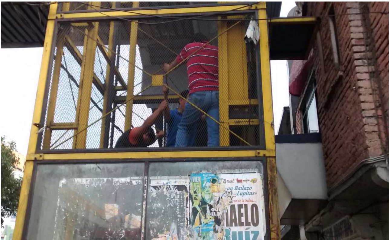
Reparación de elevador
