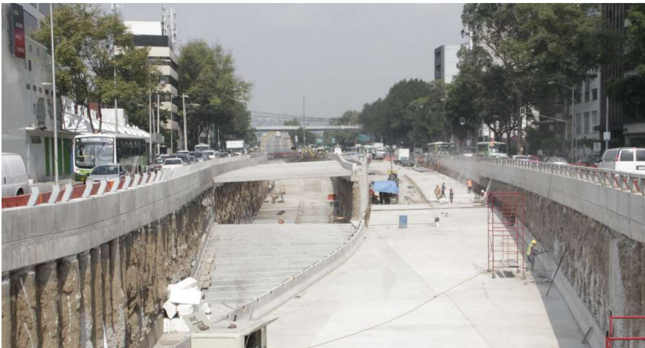
Vista del doble túnel del Desnivel Mixcoac - Insurgentes
