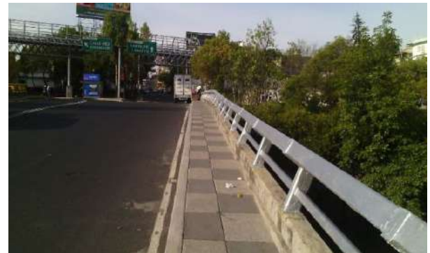
Aplicación de pintura en parapeto metálico
