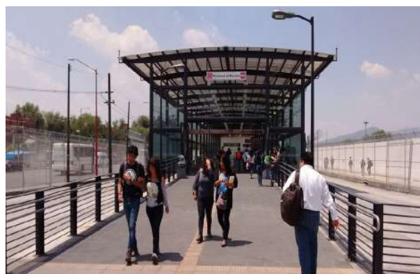
Estación terminal El Rosario con techumbre de policarbonato
