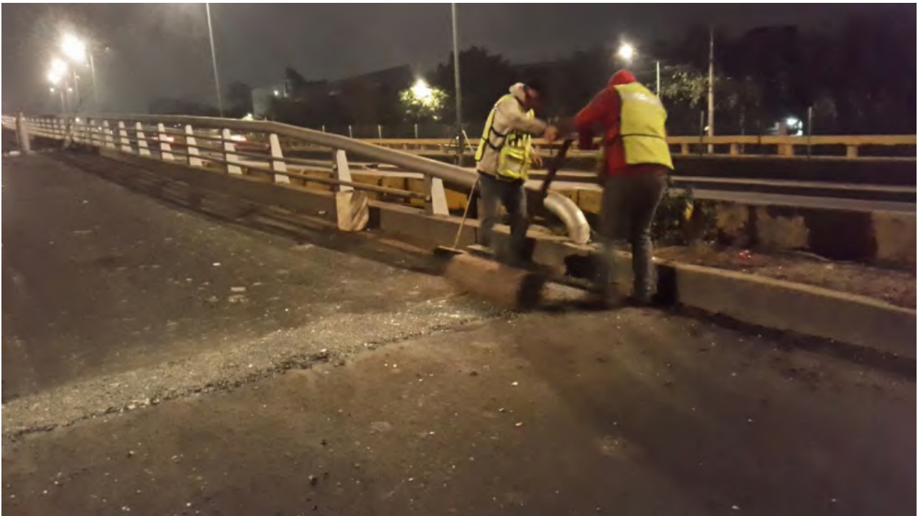
Distribuidor vial Periférico Canal de Garay
