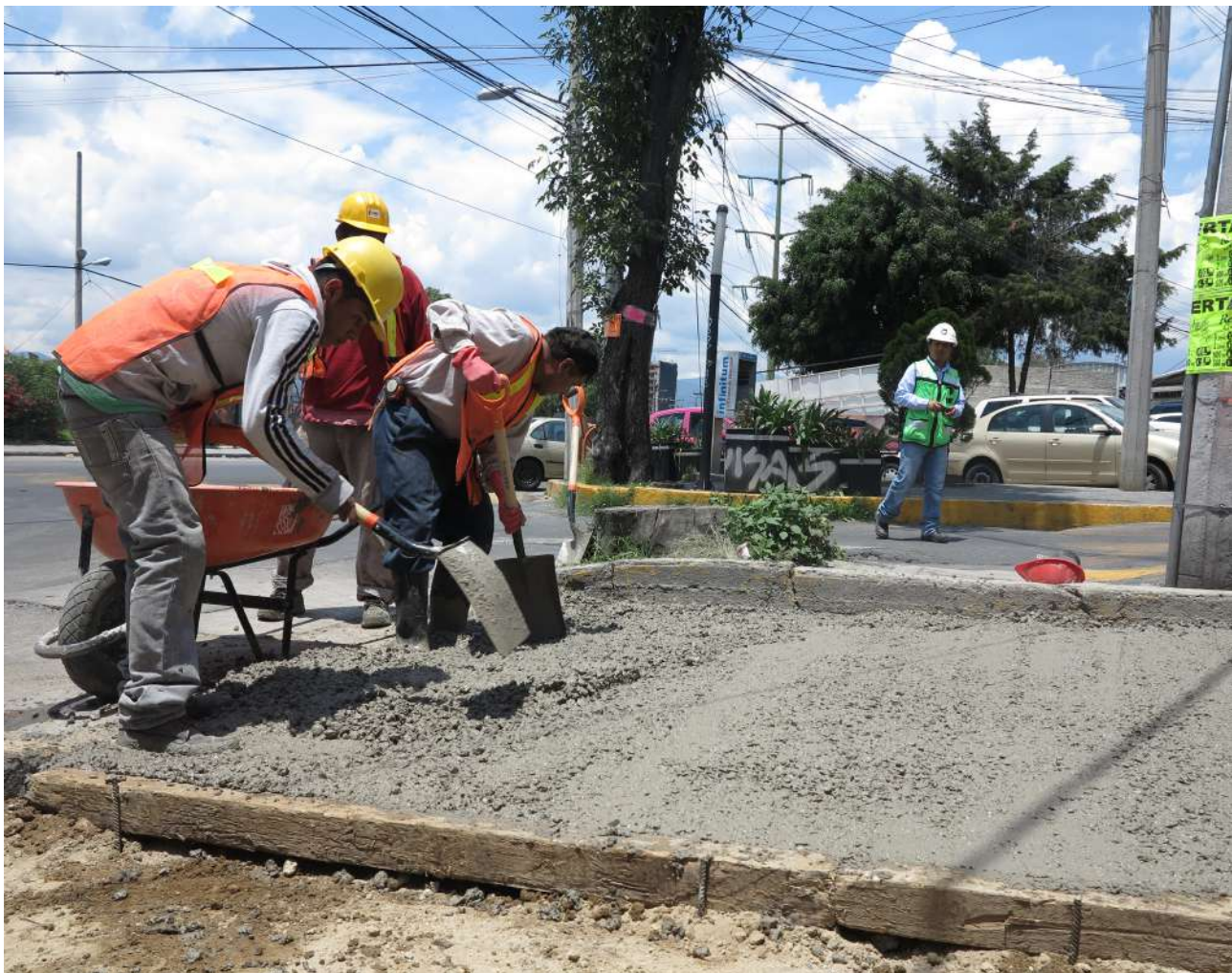
Tendido de concreto para construcción de banqueta
