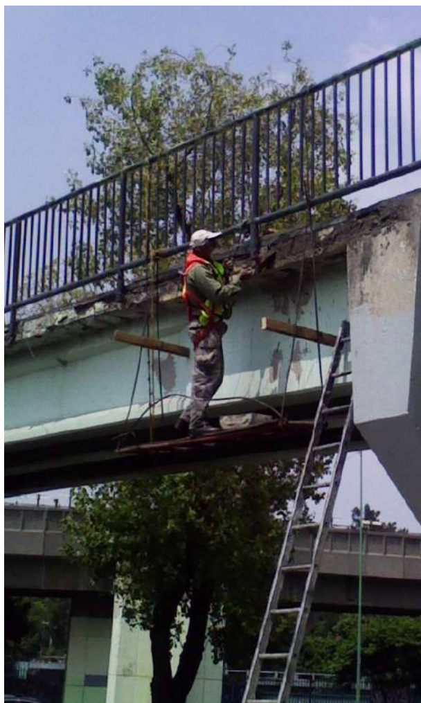
Escarificación de concreto
