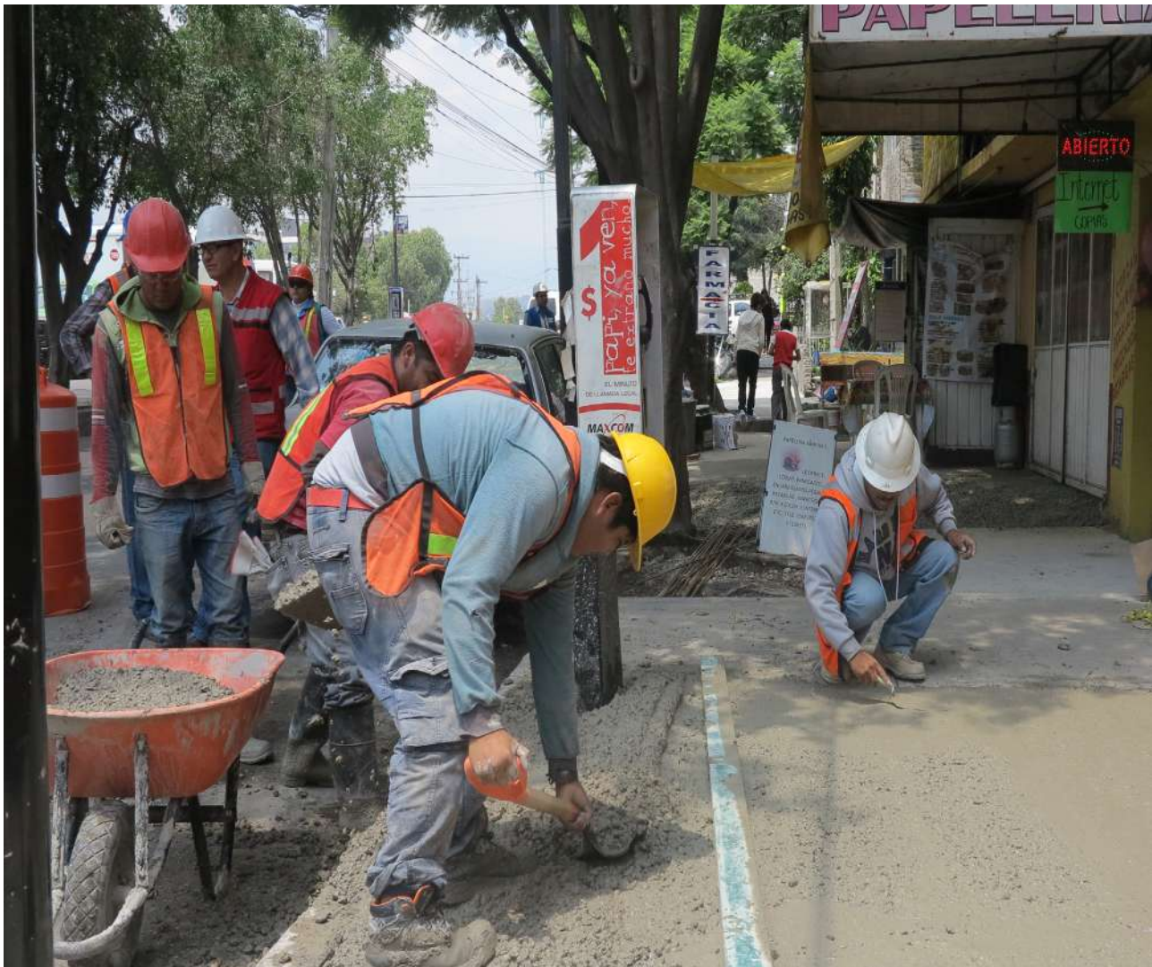
Colado en desnivel de banqueta en razo
