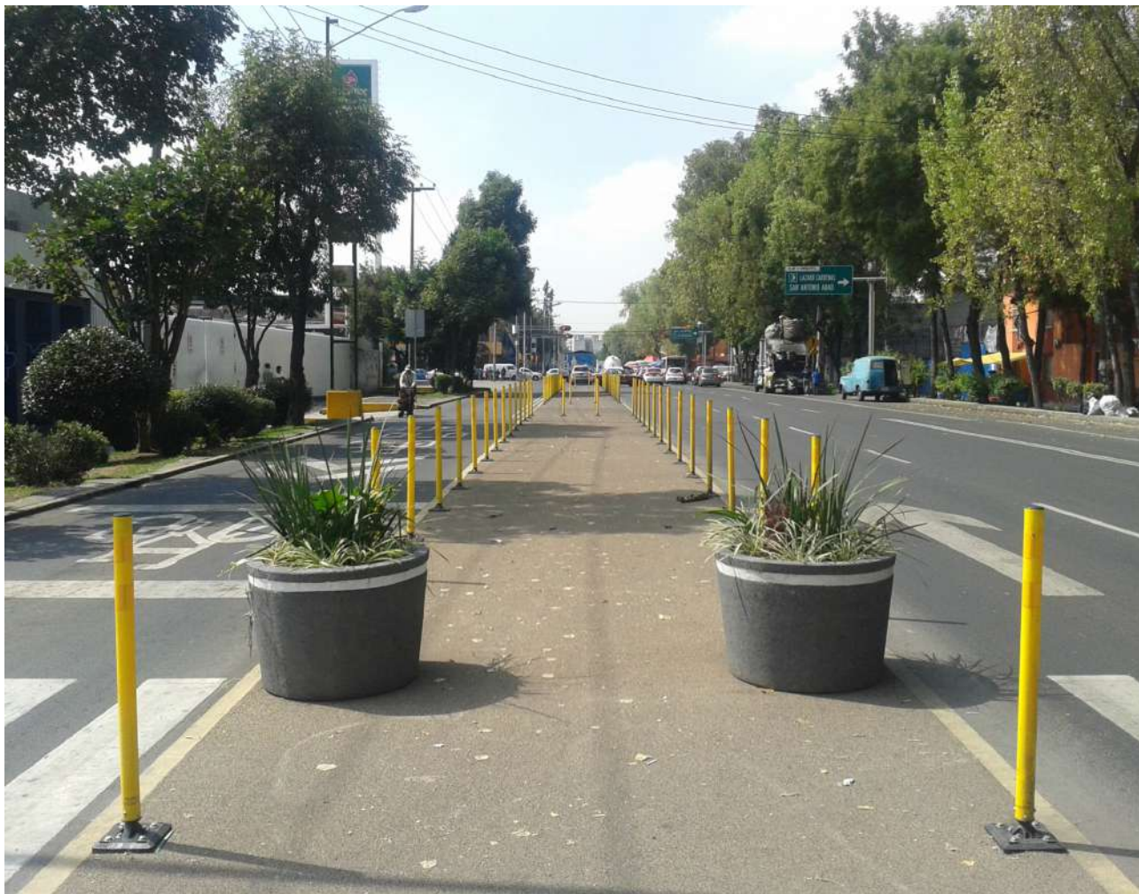
Corredor Eje 1 Oriente La Viga
