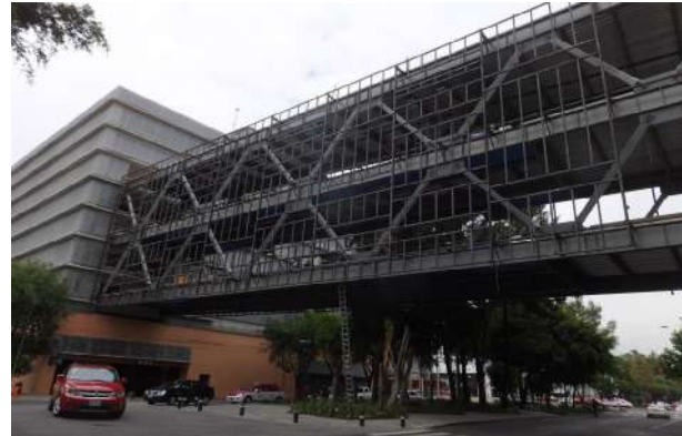
Vista del puente peatonal, elevado a tres niveles, en Avenida Obrero Mundial
