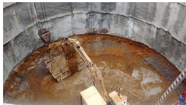
Extracción de material producto de demolición
