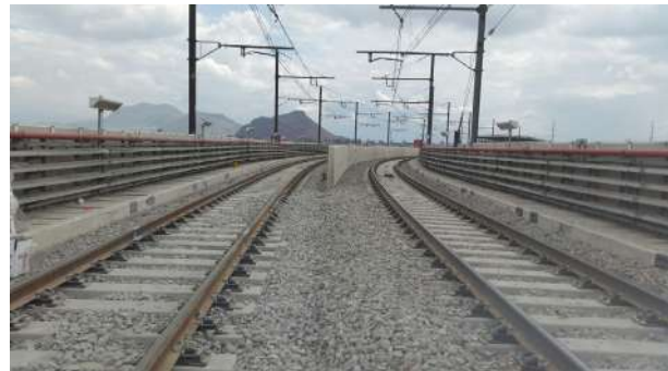
Nivelación general de vía
