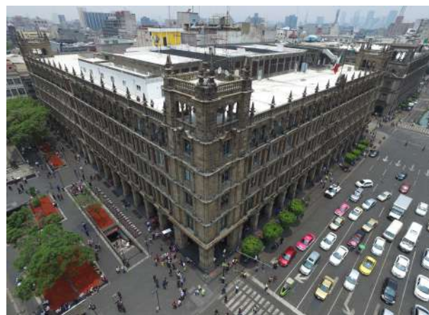
Edificios de Gobierno con instalación de celdas solares
