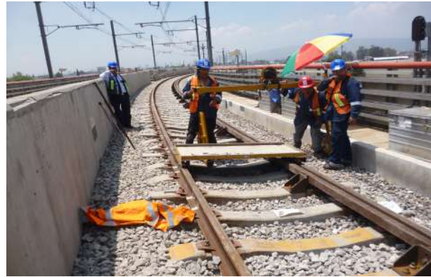
Reposición de durmientes
