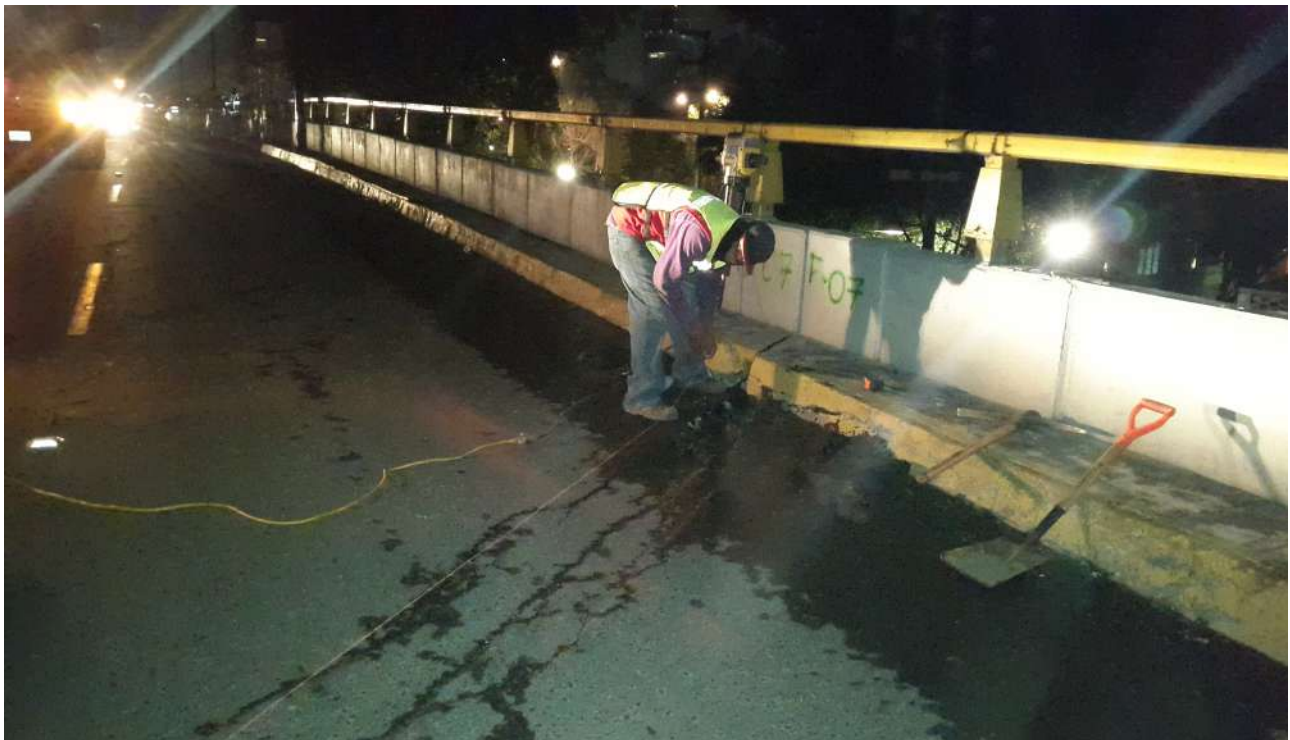
Puente en Avenida Fortuna y Eje Centraln
