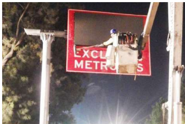
Limpeza en señalización inductiva
