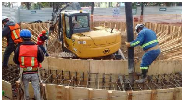
Armado, cimbrado y colado del brocal de la lumbrera
