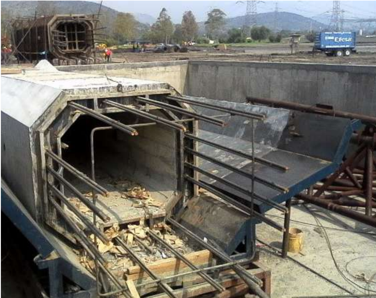
Fabricación de capiteles o remates de columnas para recibir traves
