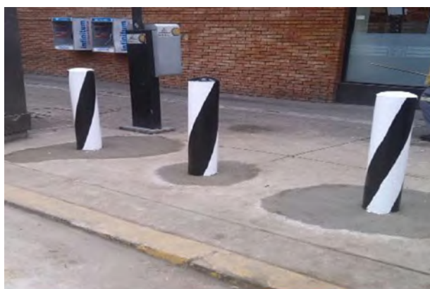
Colocación de bolardos metálicos
